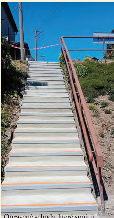
Opravené schody, které spojují ulici Malá Strana s ulicí Na Kopečku
